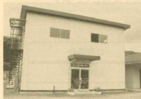
作業所の1年後に出来たプレハブの作業棟
